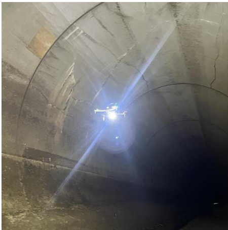
貯留管を飛行する SkydioX10
