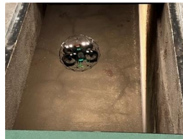
施設建屋内 BOX 部から投入する ELIOS 3
