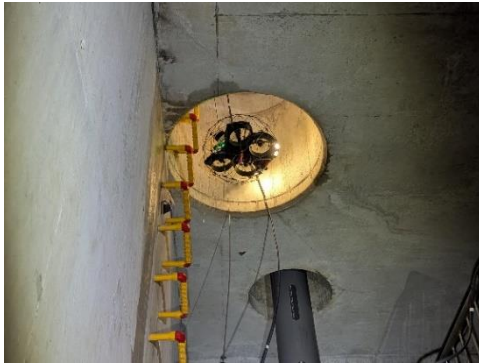
マンホールから降下する ELIOS 3
